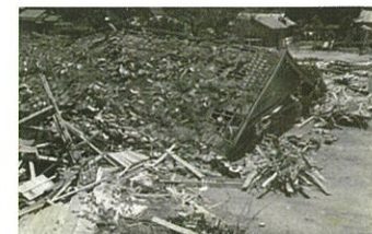
伊勢湾台風で倒壊した四郷小学校
